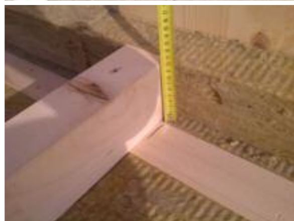
In basso, da sinistra, particolare del serramento fisso grande a sud; nodo inferiore del serramento; posa dell'XPS sul nodo inferiore del serramento.
