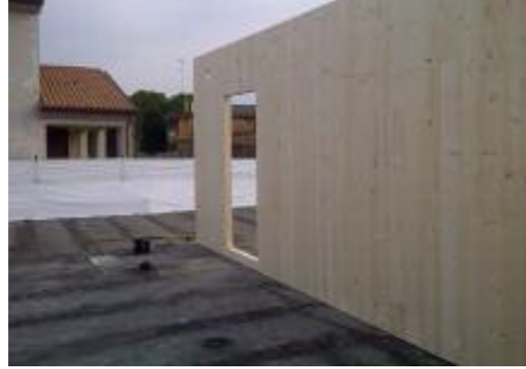
A sinistra, dall'alto: posa delle pareti in X-lam; isolamento della copertura piana; posa dell'OSB di chiusura del pacchetto della copertura piana; il taglio termico laterale della copertura.
