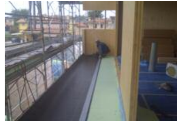
A destra, dall'alto, coibentazione della terrazza; coibentazione delle staffe di sostegno della pompeiana esterna; i falsi telai dei serramenti e il secondo strato del cappotto; lo zoccolo di partenza del cappotto in XPS; il primo e il secondo strato del cappotto; l'ultimo strato del cappotto.
