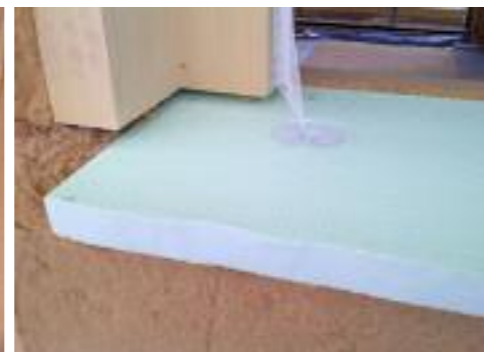
In basso, da sinistra, particolare del serramento fisso grande a sud; nodo inferiore del serramento; posa dell'XPS sul nodo inferiore del serramento.
