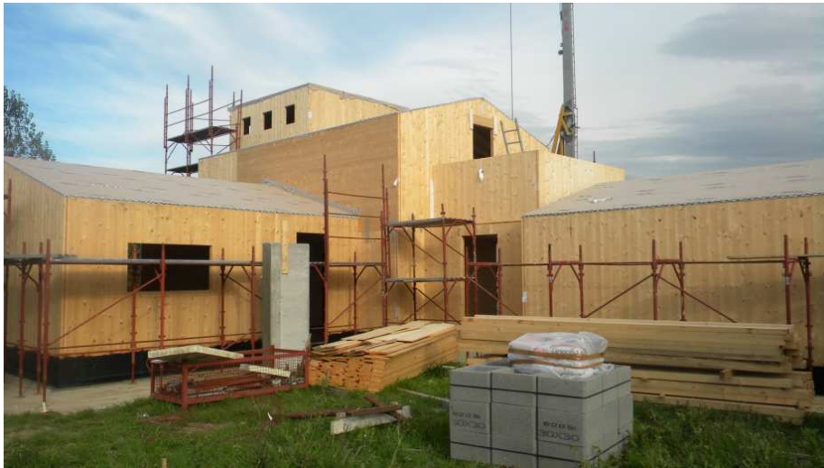
1) Struttura portante in X-LAM , inguinato alla base, coperture e solai con travi a vista sbiancate.
