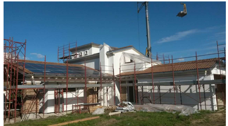
4) Applicazione di rasatura armata traspirante alleggerita, impianto fotovoltaico da 6 Kw, rivestimento pilastri in cemento armato con Geopietra.
