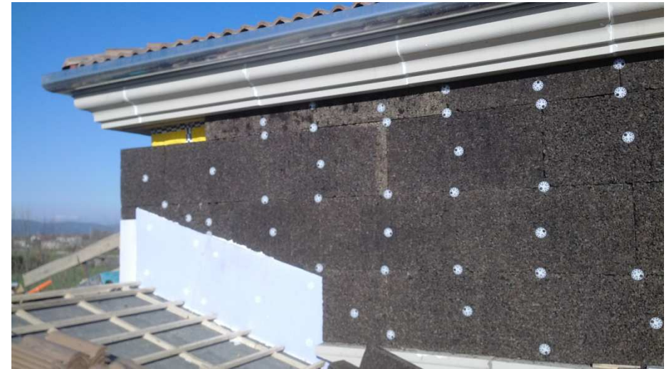
3) Applicazione di cappotto esterno in sughero brunito tostato sp. 18cm con alla base idrofobizzato per evitare risalite di umidità. Listellatura e contro listellatura per seconda ventilazione sottocoppo.
