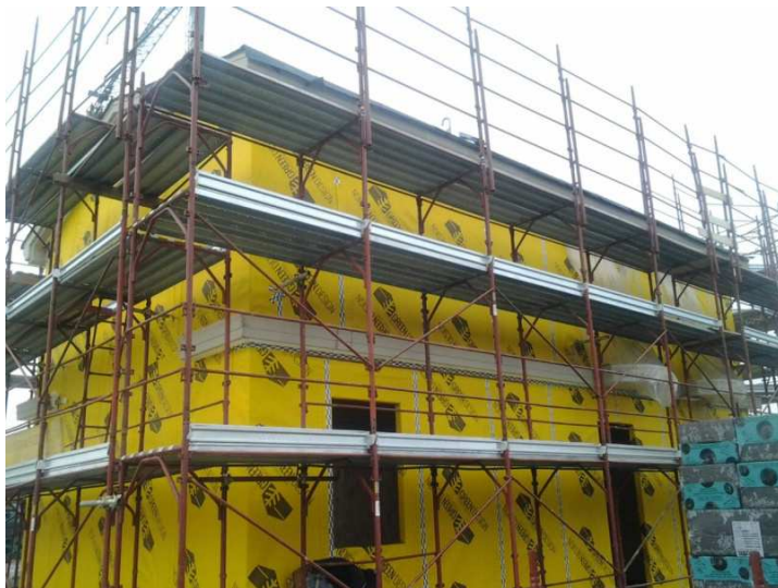
2) Posa telo tecnico traspirante nastrato di tenuta all' aria, e applicazione di cornici in EPS sagomato rivestite da resina.
